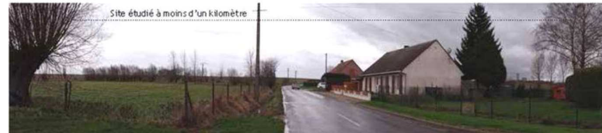
Figure 21 : vue vers le site depuis la sortie sud de Barleux sur la RD79
