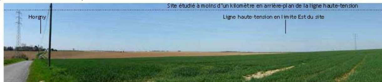
Figure 18 : vue vers l'ouest depuis la sortie ouest de Villers-Carbonnel vers Horgny
